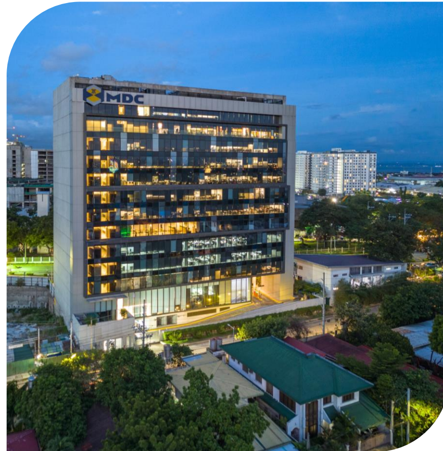
Actual site photos
